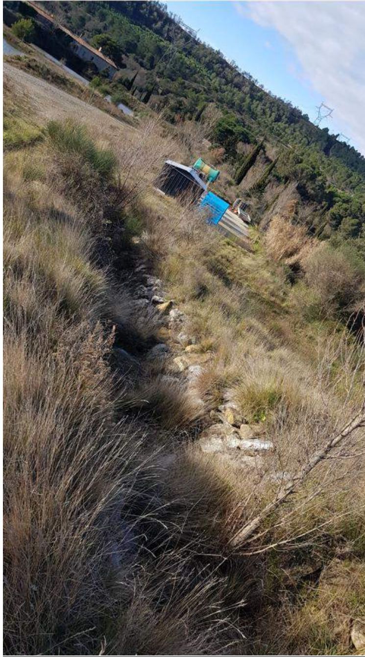
Point d'observation 27 : Fossé aval avec écoulement efficace mais végétation à couper
