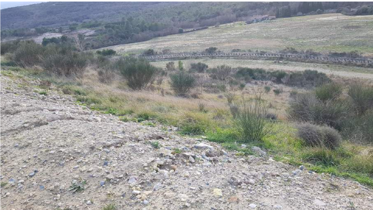
Point d'observation 2 : Ravines importantes en partie supérieure de talus avec mise à nu du DEDG
