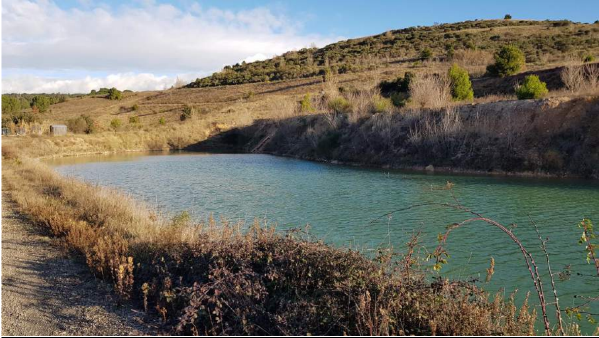
Point d'observation 8b : ravines sur talus à surveiller
