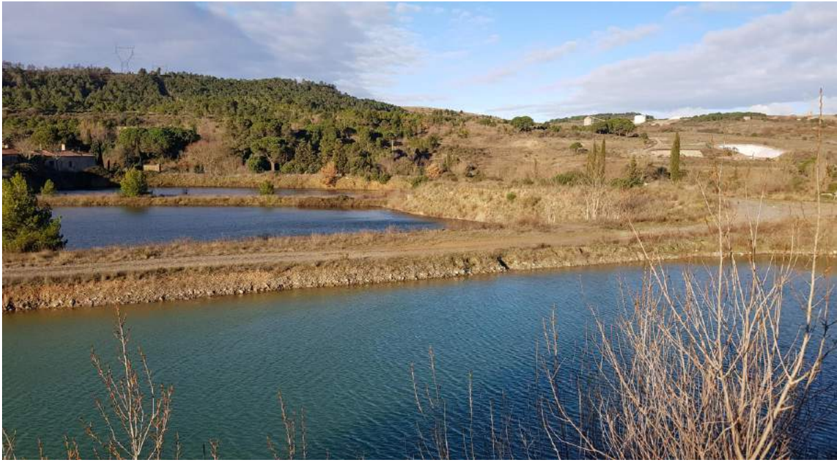
Point d'observation 8 : 4 zones d'érosion décimétriques sur la digue entre les bassins 3 et 4
