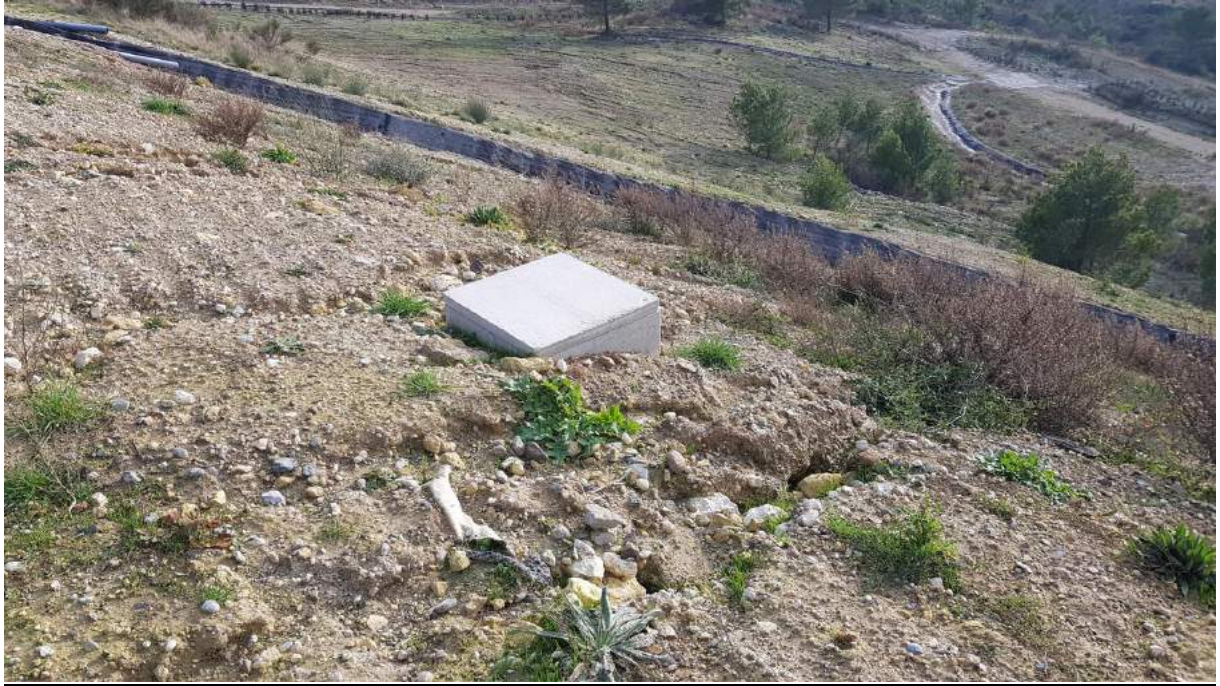
Zone 7.1 : Traces de ravinement sur talus
