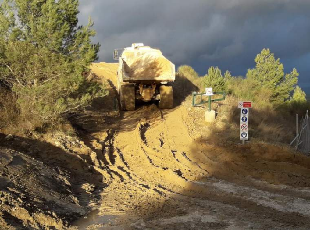
Point d'observation 1 en 2020: stockage provisoire de matériaux sur ancienne zone glissée et reprise
