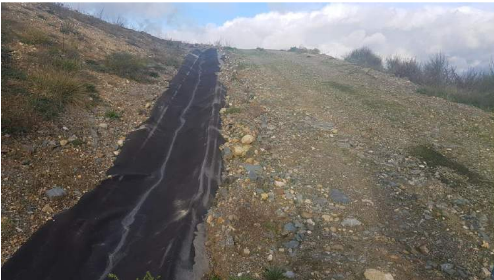
Point d'observation 1 en 2022 : reprise talus et fossé
