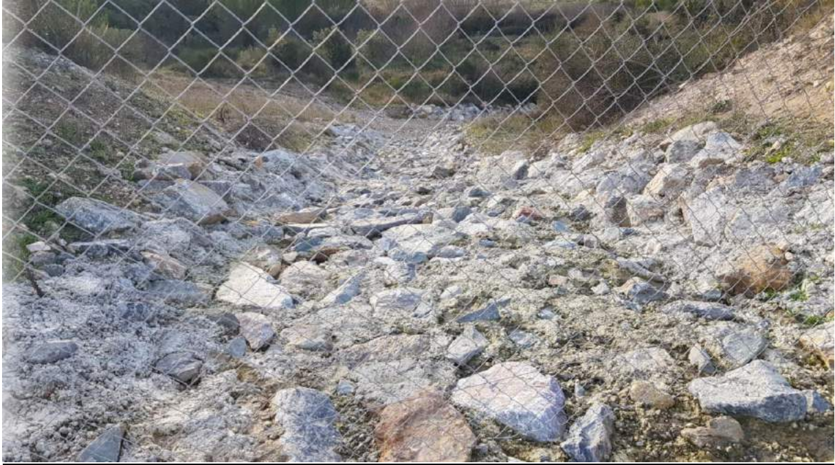
Point d'observation 8b : exutoires avec enrochements bétonnés
