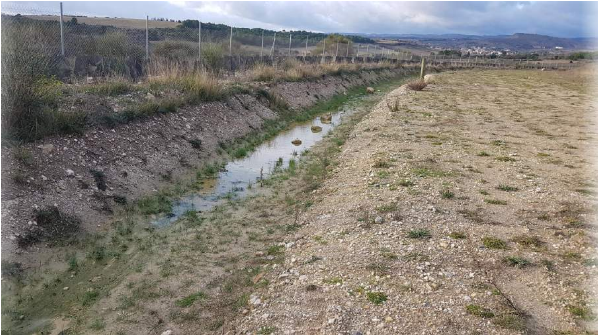
Point d'observation 8 vers le Nord /Ouest : fossé reprofilé et recalibré avec zones de stagnations d'eau résiduelles
