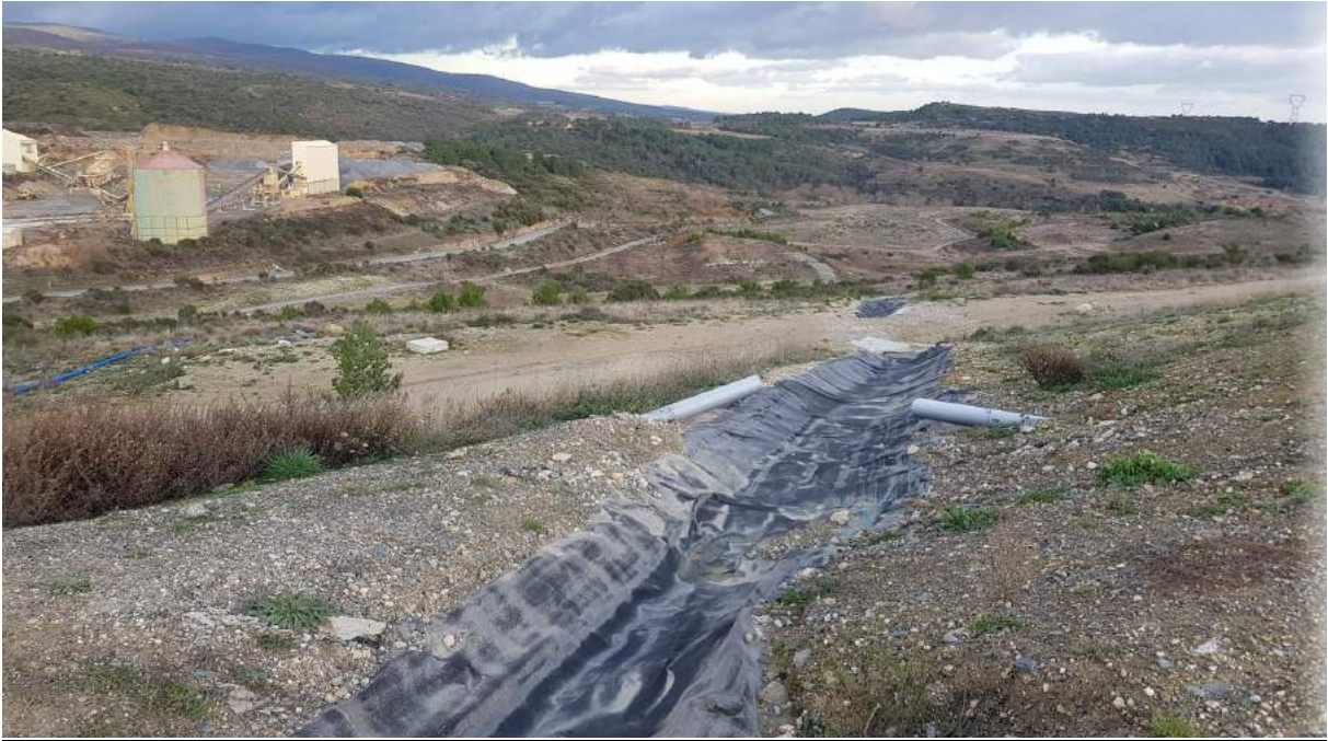
Point d'observation 11 : Erosion des matériaux en amont et au niveau de l'ancrage du DEDG
