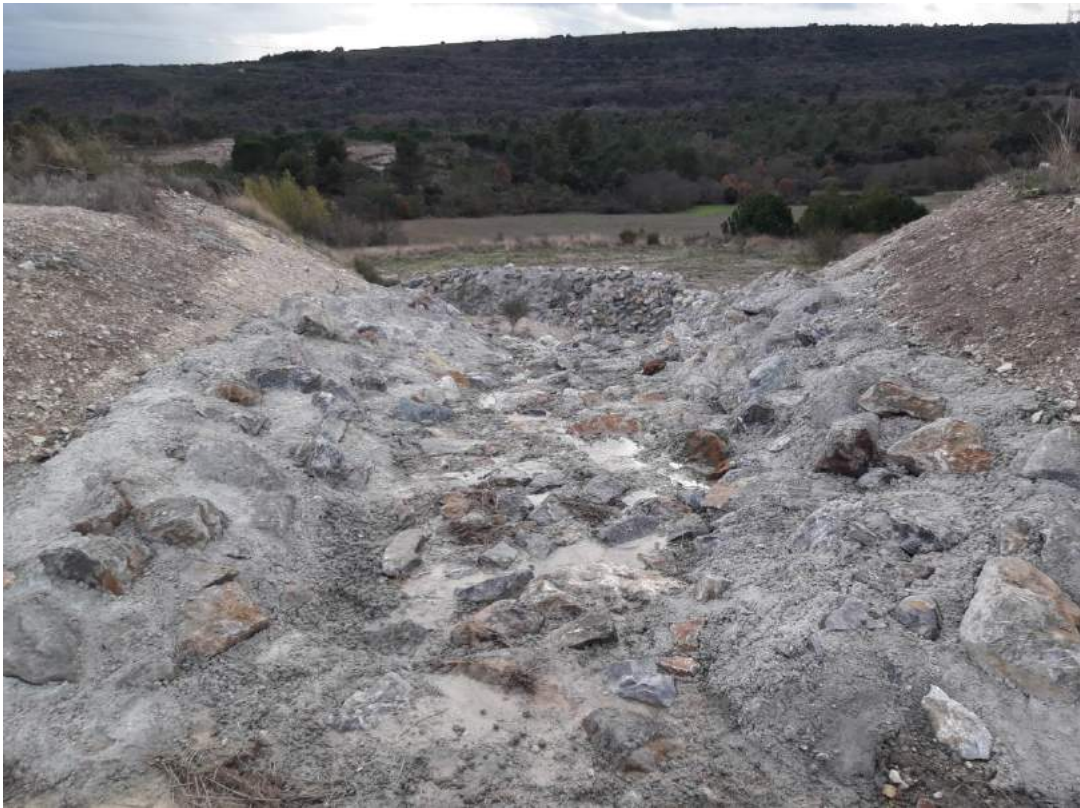
Point d'observation 8a : exutoires avec enrochements bétonnés
