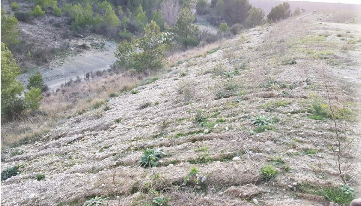
Point d'observation 2 : Ravines importantes en partie supérieure de talus avec mise à nu du DEDG
