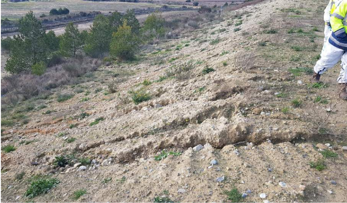
Zone 7 : Vue d'ensemble depuis le Sud-Est de la zone 7 avec traces d'érosion
