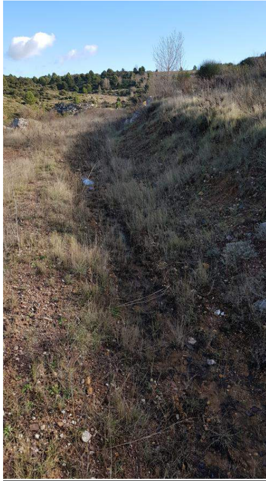
Point d'observation 3 : Fossé à recalibrer avec dépôts de stériles avec stagnations d'eau
